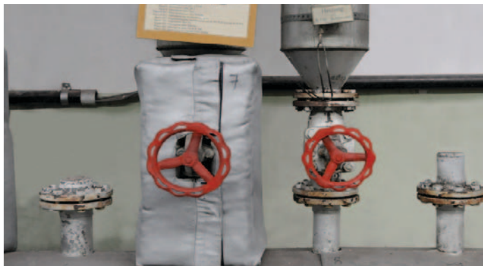
Vergleich eines gedämmten (links) und ungedämmten (rechts) Dampfventils.
