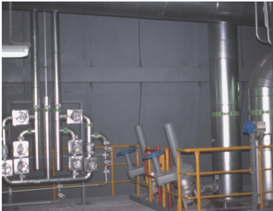
Farbfoto der Kesselwand
