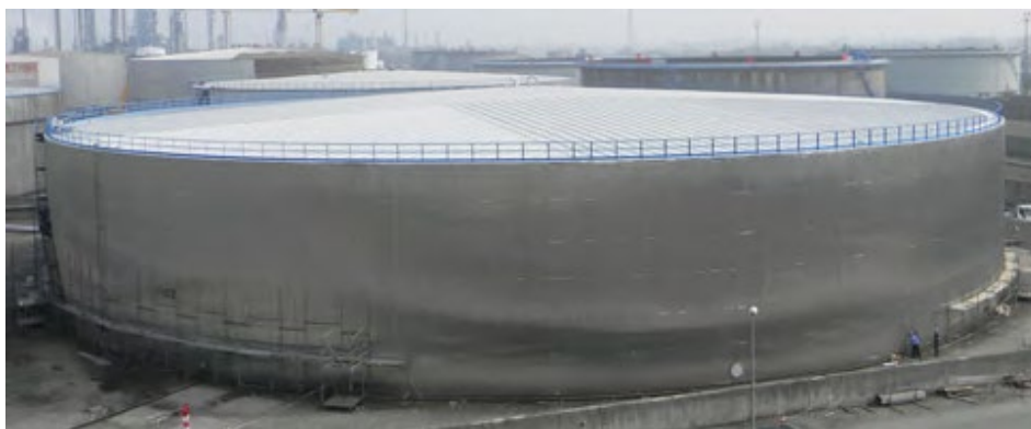
Bild 12: Isoliertes Tankdach nach der Sanierung 1
