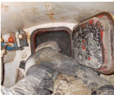
Abbildung 10: Arbeiten an der Ortsbrust bei geöffneter Einstiegs Luke Quelle: BAK
