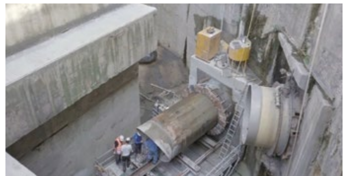
Abbildung 7: Einfahrvorgang – Vorschub in Zielschacht
