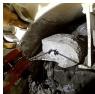
Abbildung 22: Vortrieb DA 2700, natürliches Hindernis, Granitblock, Stein (L x B x H = 100 x 80 x 50 cm)
