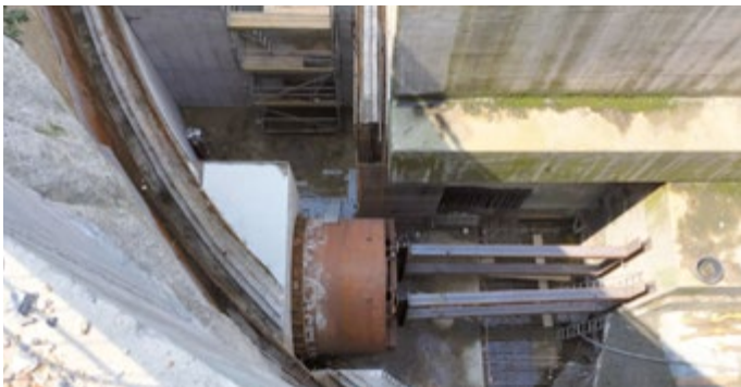
Abbildung 6: Einfahrvorgang – Drucktopf mit Abstrebung
