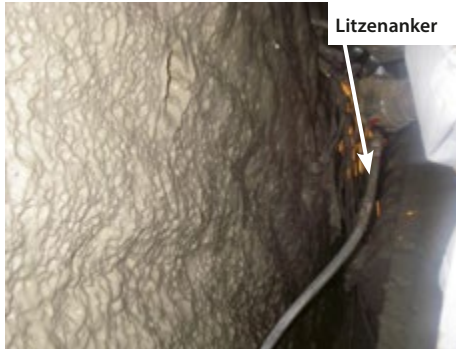
Abbildung 24: Hindernisbeseitigung Litzenanker im Mixschild DA 4400 Quelle: BAK
