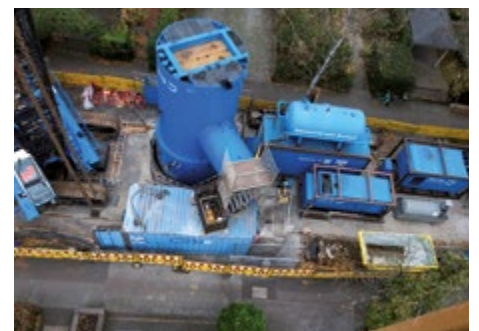
Abbildung 15: Caissonschleuse – Ausführungsbeispiel Quelle: BAK
