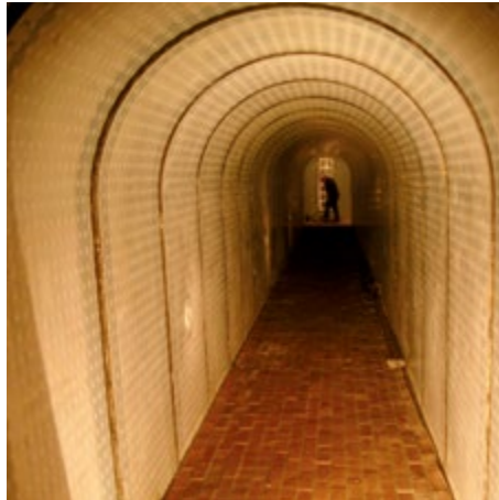
Abbildung 27: Blick aus dem Vortriebsrohr DN 3600 in Richtung Schachtausstieg – Sacklochbohrung Quelle: BAK
