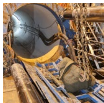
Abbildung 21: Bergung von Findlingen aus der Teilschnittmaschine DA 2240
