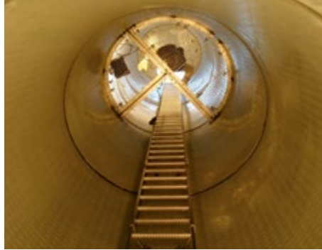
Abbildung 26: Blick von der Schachtsohle in Richtung Ausstieg zur Oberfläche – Absenkschacht Quelle: BAK
