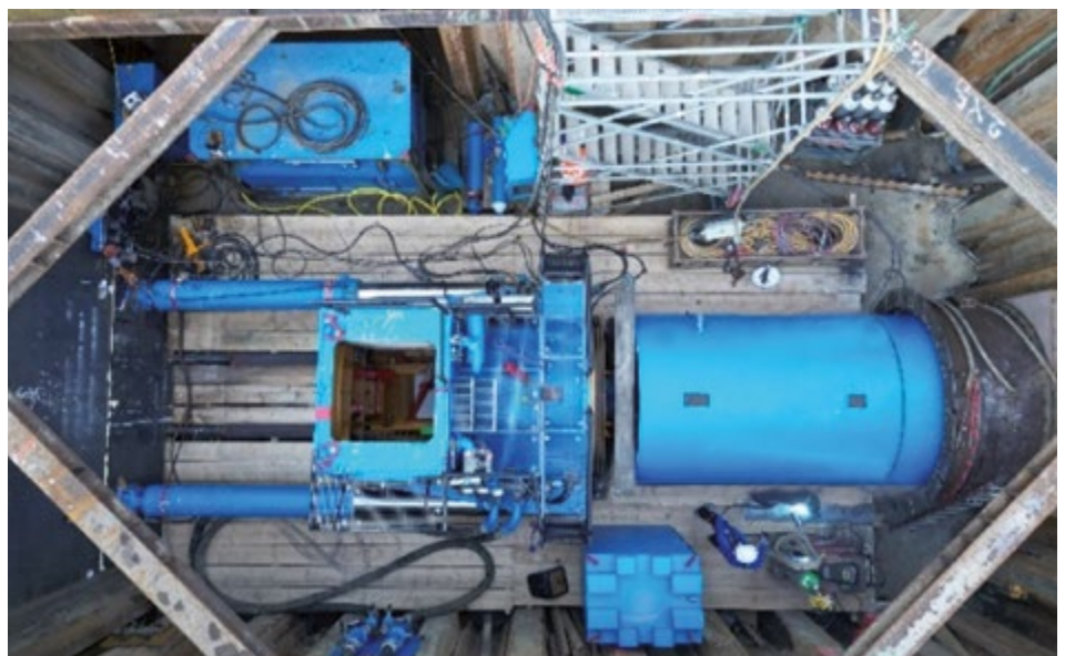
Abbildung 9: Ausführungsbeispiel einer Kompaktschleuse
