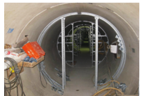
Bild 11 (Wayss & Freytag Ingenieurbau AG)
