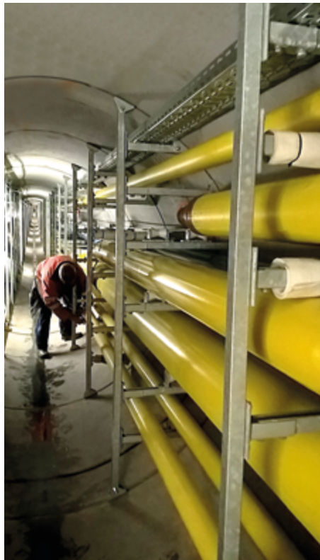
Bild 14 (Wayss & Freytag Ingenieurbau AG)
