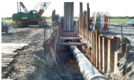
Bild 12 (Wayss & Freytag Ingenieurbau AG)
