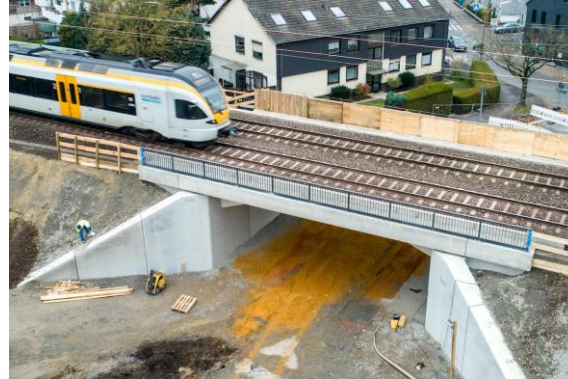
Bahnbau: nach 18 Tagen Ende der einzigen Sperrpause
