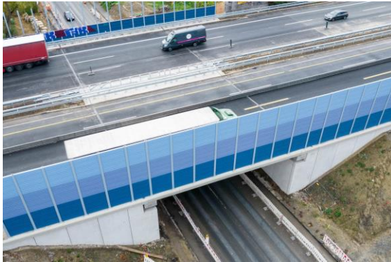
Autobahnbau: in nur 9 Wochen: Abbruch, Neubau bis Verkehrsumlegung; nach 20 Tagen Auflegen des Überbaus in Endlage
